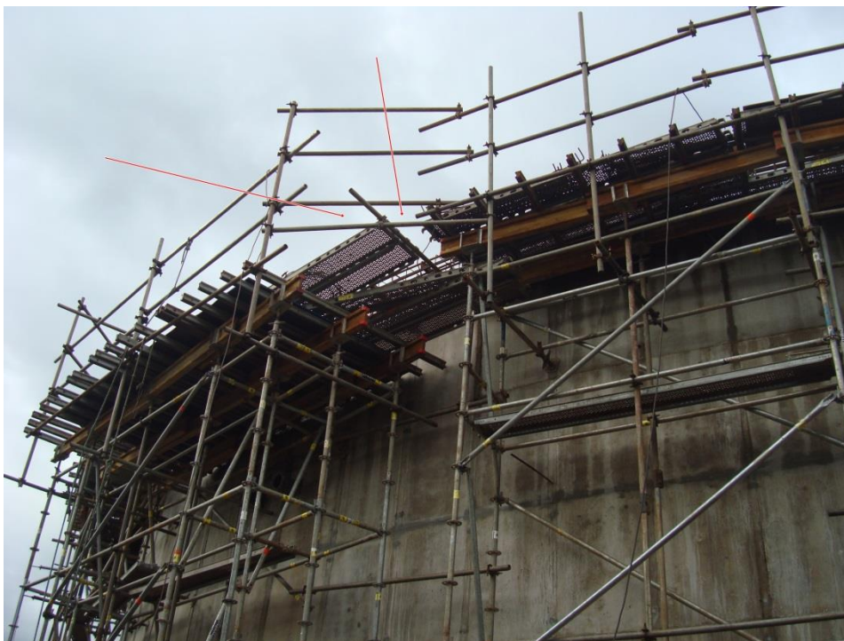
Figura 21 – Andaime com abertura no piso. Fonte: Arquivo Pessoal.
