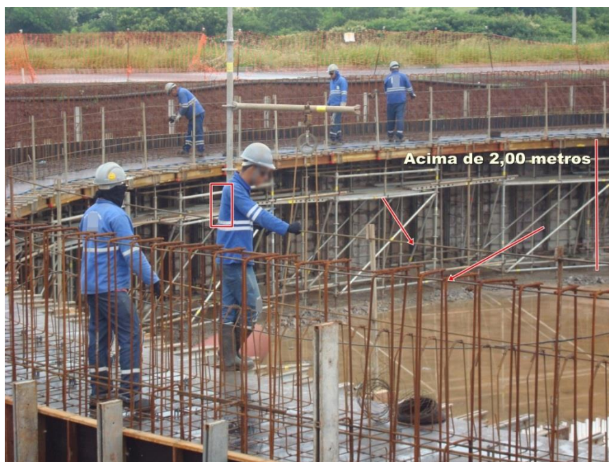
Figura 18 – Colaboradores exercendo atividades em altura sem os EPIs específicos.
