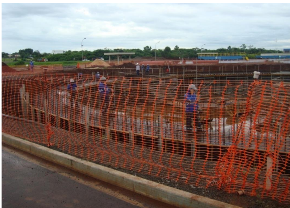
Figura 15 – Isolamento da área com cerquite. Fonte: Arquivo Pessoal.
