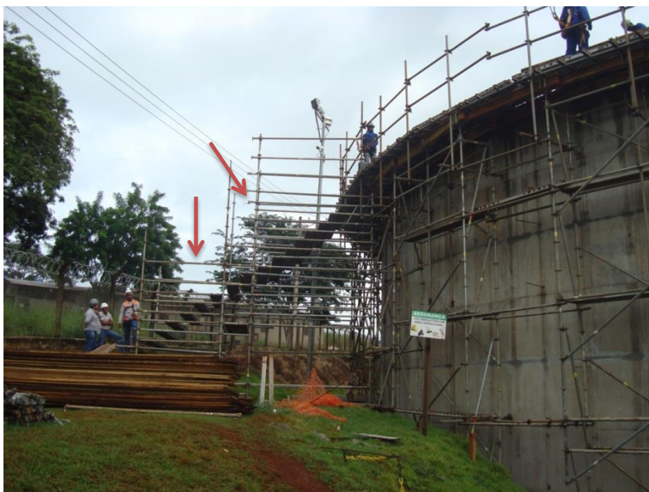
Figura 17 – Escadas de acesso com corrimão. Fonte: Arquivo Pessoal.
